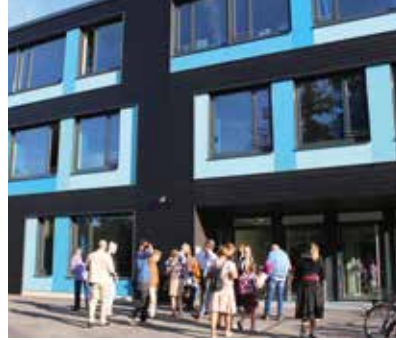
Am ersten Schultag war am neuen Schulgebäude schon viel los.
