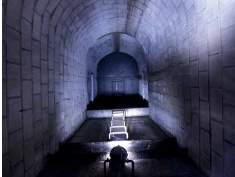
Der Notausstieg des Bunkers. Foto: Norbert Hans (Bunkerfreunde München).
