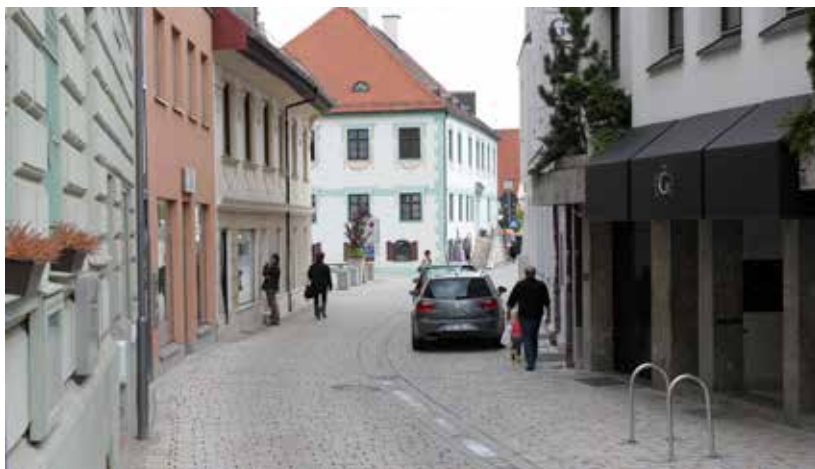
Seit einigen Wochen ist nun die Sanierung der Sonnenstraße abgeschlossen.
